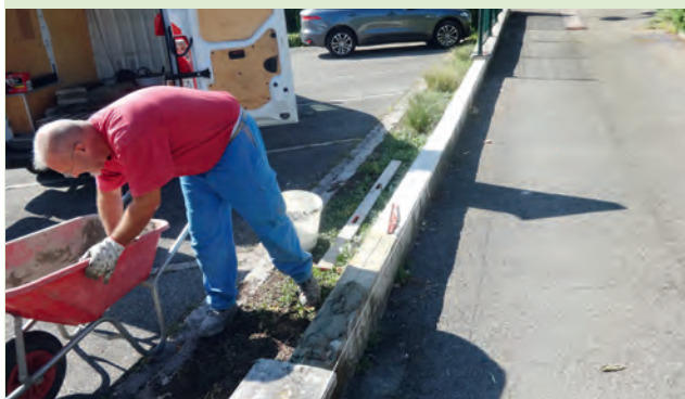
Pose de couvertines derrière l'église
