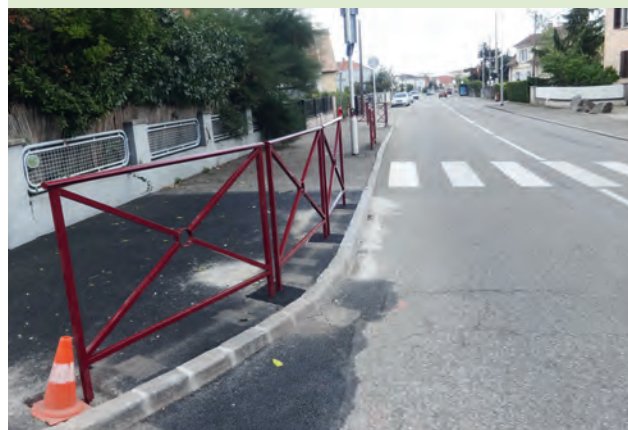
Installation de barrières route de Colmar / rue Pasteur
